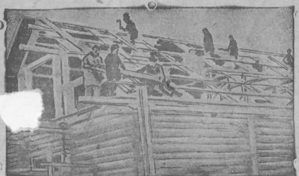
Строительство зернохранилища в колхозе „Пионер“
