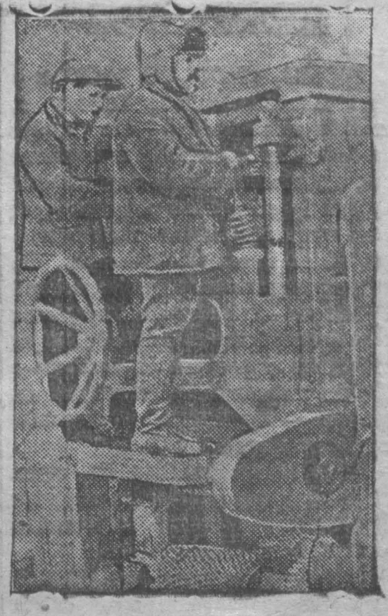
Сборка лесопильной рамы на строительном дворе Азотстрой.
