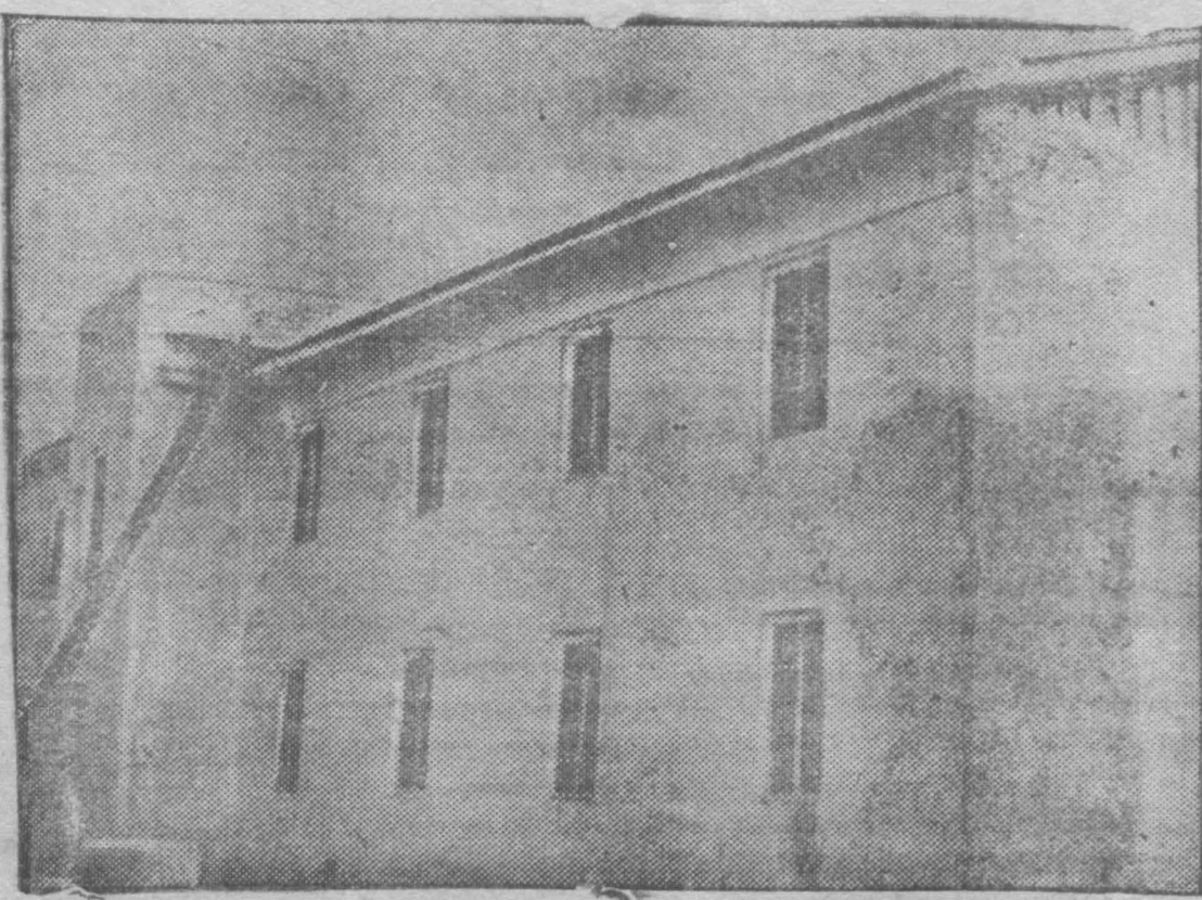
Общий вид нововыстроенного дома на втором участке Жилкомстроя.
