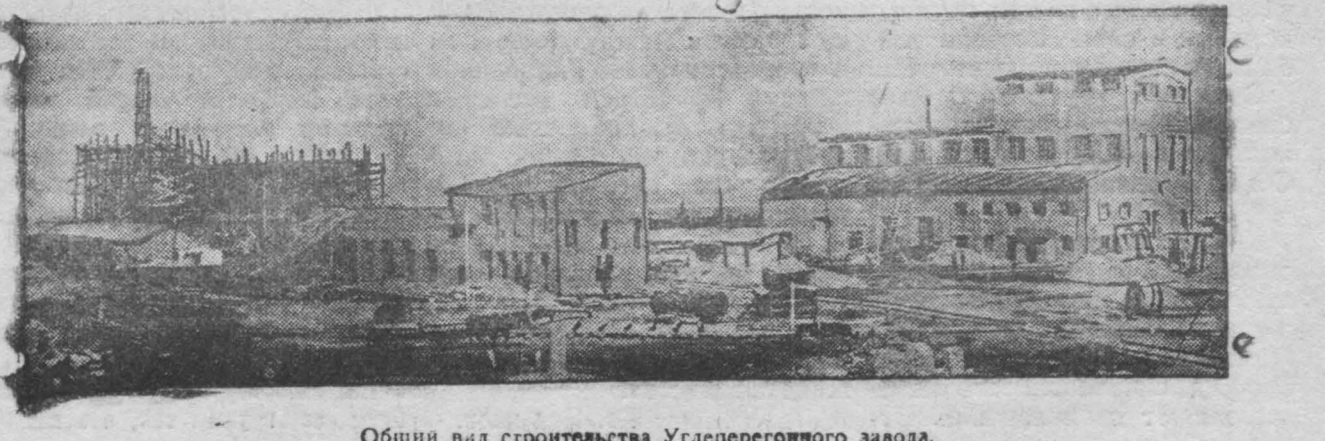
Общий вид строительства Углерегонного завода.
