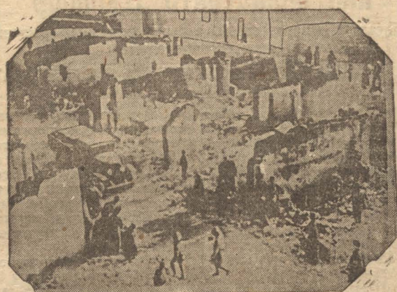
На снимке: разрушенный квартал в Шанхайгуане.
