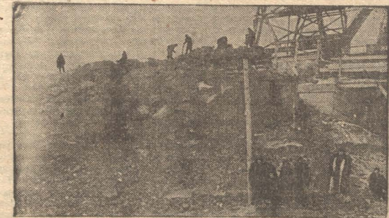
14-ти метровая насыпь поймы у моста, ударниками поймы окончена в срок 15 го января 1933 года.
