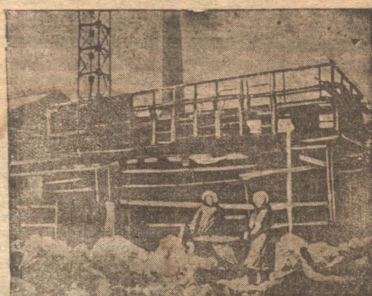
Тепляк для коксостройки. Для быстрого окончания строительства необходимо сейчас же забросить нужное количество леса и из котлована откачать воду.
