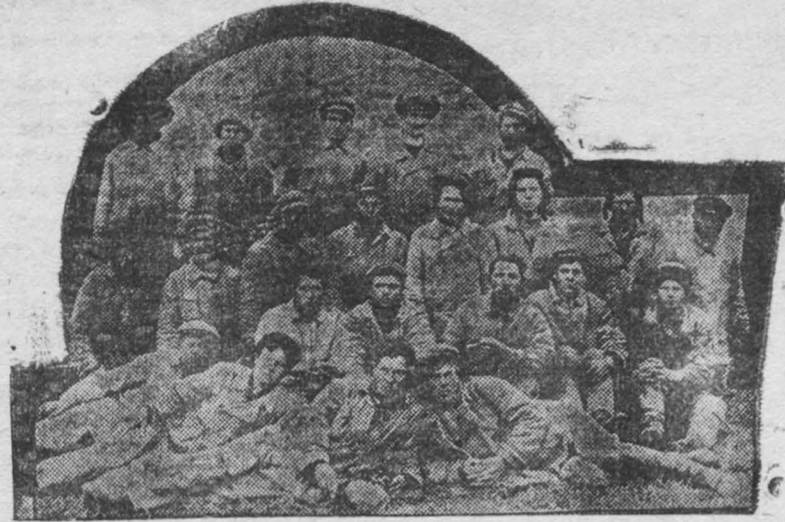
На СНИМКЕ: Ударная бригада Бакирова, показавшая образцы ударной работы на прокладке труб водопровода.
