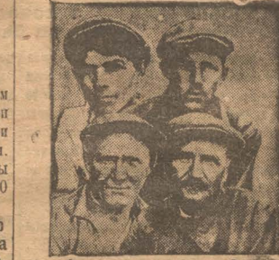
Лучшие ударники из бригады Яхля Цинкстрой, Бригада выполнит задание на 200 проц.
