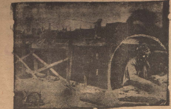
НА СНИМКАХ Стройтреста ТЭЦ. В центре ударник из бригады Бардосова т. Лисичкин.
