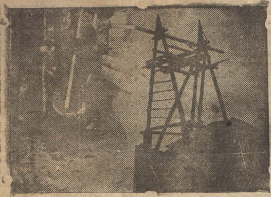
Для использования электроэнергии Кемеровской ТЭЦ строится линия проводов Кемерово—Ленинск. Постройка будет закончена в июле с. г. На снимке—установка и укладка столбов линии.
