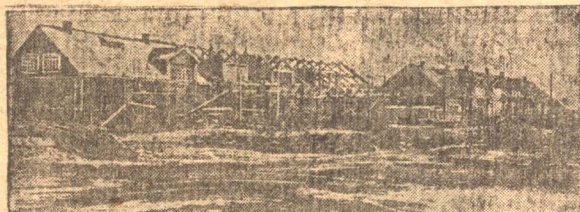
На снимке: Кузбасстрой строит дома для рабочих
