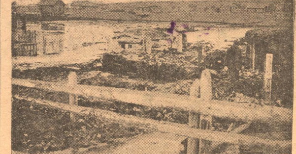
НА ФОТО: Место, где будет строиться щеголовский дом советов. Сейчас на этом месте лишь полуразрушенные хибарки и груды строительных материалов.
