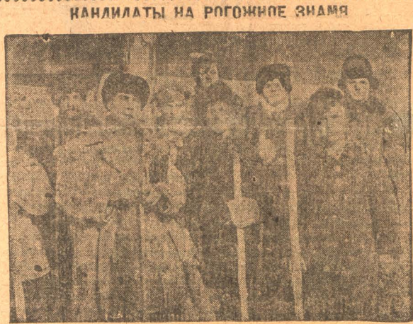
Бригада землекопов 6. Рыманова (теперь Серебрянникова) на Энергстрое объявила себя ударной. Но в днях эта группа покрыла себя позором — в самый ответственный момент она в полном составе прогуляла две смены
