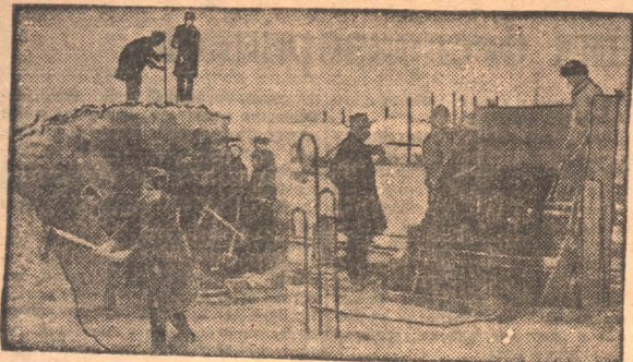
На снимке:—Слева—воскресник студентов металлургического техникума в фонд дирижаблестроения. Справа—бетонировка башмаков машинного отделения.
