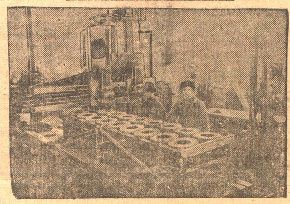
Ни снимке: Строгальный станок, беспрерывно работающий по изготовле- нию оборудования для новых коксовых печей
