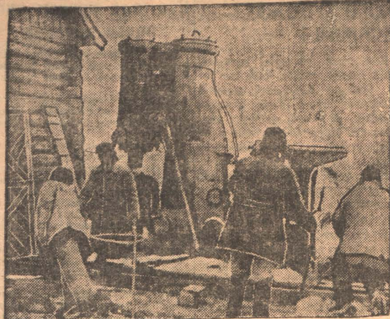
На Коксострое получен новый электрический молот. НА СНИМКЕ:—Молот втаскивают в кузнечный цех.
