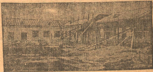
Постройка зданий для мастерских школы ФЗУ
