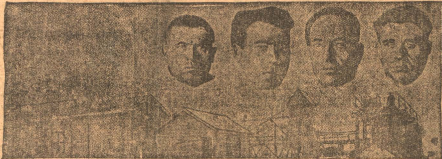
Общий вид Алмазевской шахты. В центре группа альпинистов из коммуны "Восход" Шагурского района, приехавшие помогать алмазевцам в ликвидации провала.
