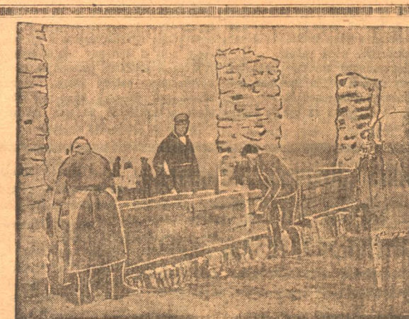
Овощно-молочный совхоз «Ториян». Постройка теплых дворов. Дворы строятся по комбинированной системе: фундаменты и столбы — каменные, а простенки из смеси глины, песка и навоза.
