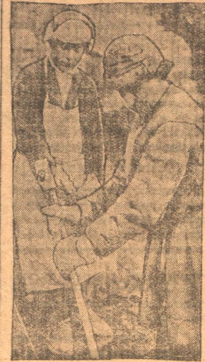
Забутковна сиважины для взрыва камня на Мозжукинском карьере
