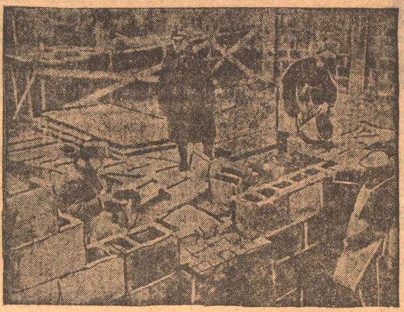
На стройке сапрелевого завода
