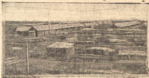
На стройке Кузнецкого завода.
