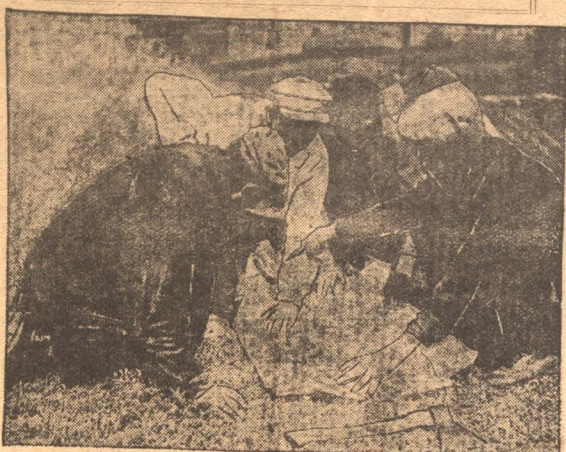
НА СНИМКЕ: Разбивка места под здание заводу управления на Кокострой.
