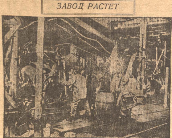
НА СНИМКЕ: Бетонировка новых скуберов (аппараты для химической переработки продуктов) в новом химическом отделении Кемеровского завода.
