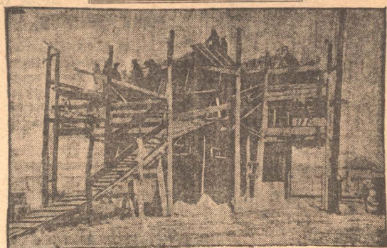
НА СНИМКЕ: Строющийся Кемеровский коксо-химический завод.
