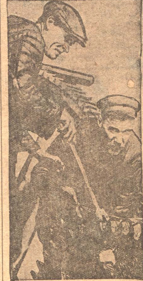
Судоремонтные мастерские в Ленинграде закончили ремонт земкарavana на 20 дней раньше срока. НА СНИМКЕ: Закачивают ремонт землечерпалки «Фурфан».
