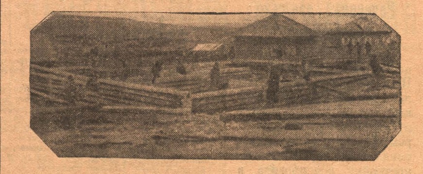
Школа в д. Усть-Искитимке, строящаяся на средства самообложения
