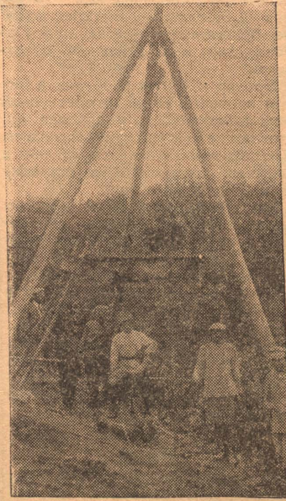
Разведочные работы путем бурения. Изучаются пласты угля.
