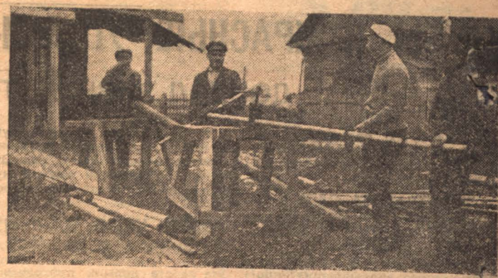
В городе идут водопроводные работы. НА СНИМКЕ: Готовят трубы для укладки
