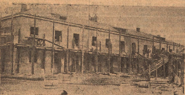
На берегу Томи, возле больницы, строится здание окружкома
