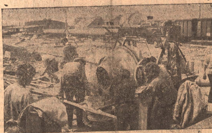
НА СНИМКЕ: цементные работы на постройке третьей батареи коксовых печей
