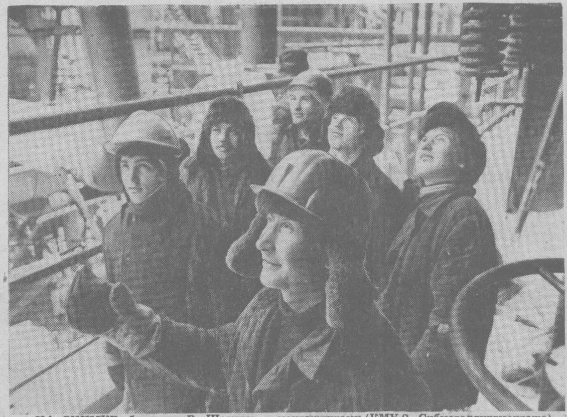
НА СНИМKE: бригадир В. Шатунов с монтажниками (КМУ-2 Сибметаллургмонтажа). Фото В. Грызыхина.
