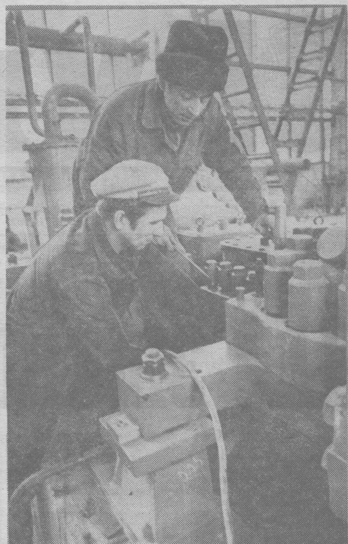
НА СНИМКЕ: Монтаж компрессора природного газа. Фото В. Грызыкина.
