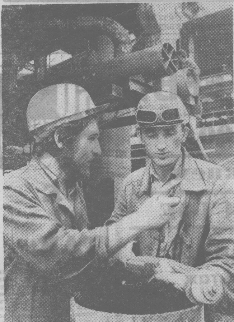
Трубопроводы корпуса 675 монтирует бригада А. Колдеркина из Сибметаллургмонтажа, побеждая в соцсоревновании самые сильные коллективы. НА СНИМКЕ: А. Колдеркин и газорезчик В. Цветков. Фото П. Костюкова.
