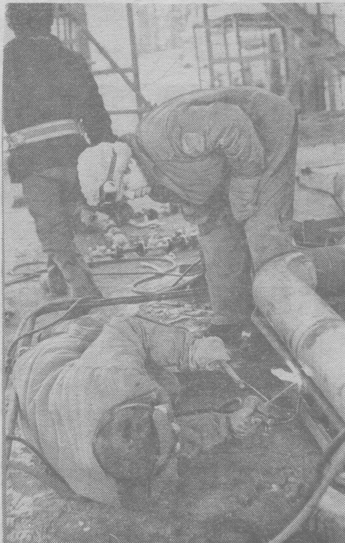
И такой бывает работа сварщиков.
