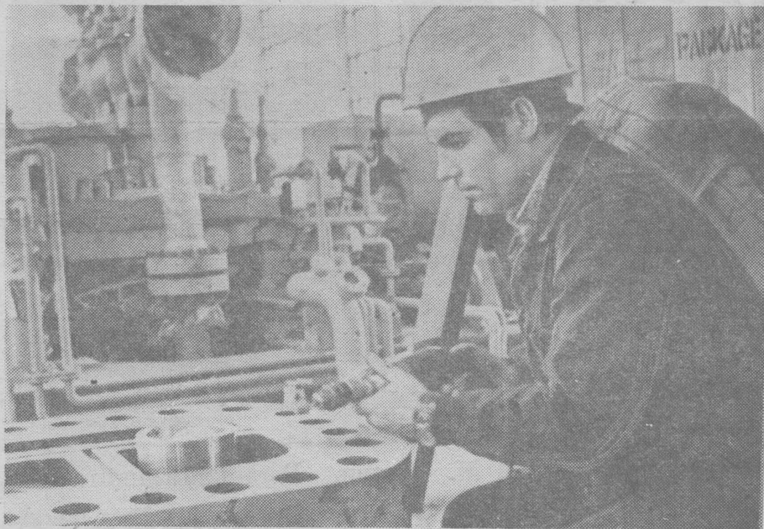
НА СНИМКЕ: слесарь-монтажник из КМУ-1 Н. Бочанов.
