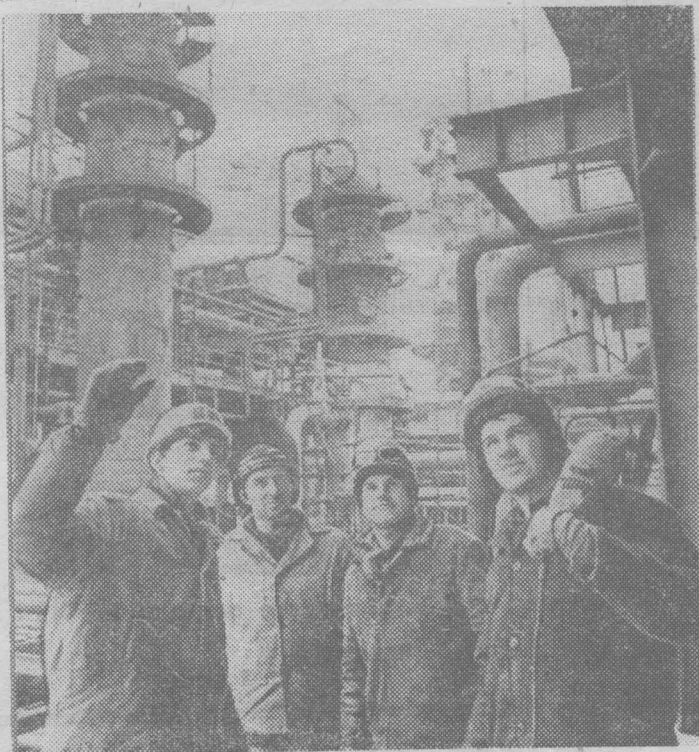
Монтаж технологического оборудования в 674 корпусе ведет бригада О. Сдобыева из КМУ-2 Сибметаллургмонтажа.
