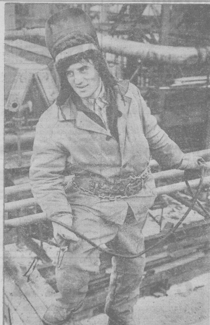
НА СНИМКЕ: сварщик Анатолий Пахомов из бригады В. Носова КМУ-2 Сибметаллургомонтажа ведет сварку трубопроводов технологического оборудования.
