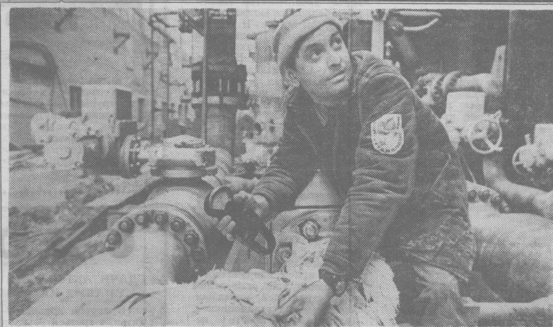
НА СНИМКЕ: оператор-термист Е. Соловьев из КМУ-1 Сибметаллургмонтажа проверяет ток в нагревателе сварочного стыка. Фото В. Грызыкина.
