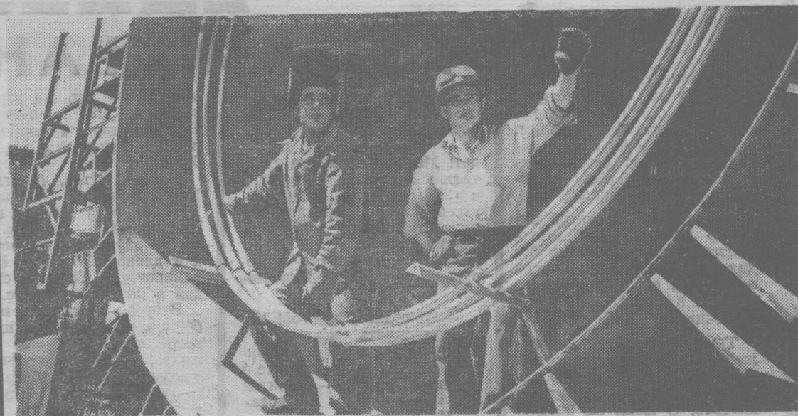
На помощь строителям аммиака-2 приехали специалисты завода «Пензахиммаш». Они монтируют абсорбер.
