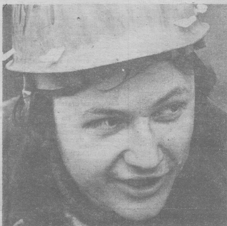
НА СНИМKE: А. Ивашин — один из лучших монтажников бригады А. Колдеркина (Сибметаллургмонтаж). Фото Б. Иванова.
