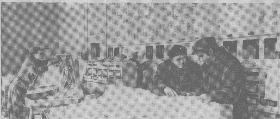
Монтаж ЦПУ ведет бригада Л. Смолехи из Уралмонтажавтоматики.
