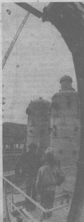
На снимке: блок 1,3 корпуса № 673. Фото Ю. Сергеева.
