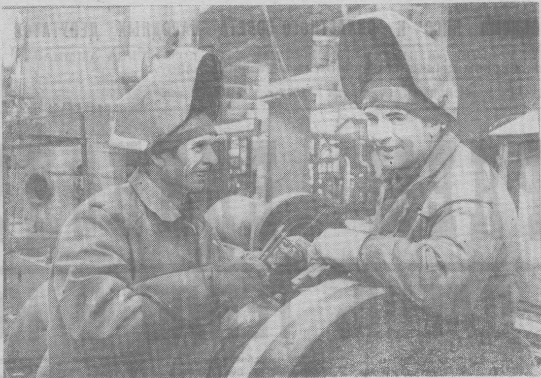
Иов Воронов и Евгений Васильев — опытные сварщики 3-го участка КМУ-1 Сибметаллургомонтажа, в полной мере овладевшие секретами своей трудной профессии. Сейчас им поручена сварка толстостенных труб высокого давления, соединяющих компрессор синтеза газа с колонной синтеза.
