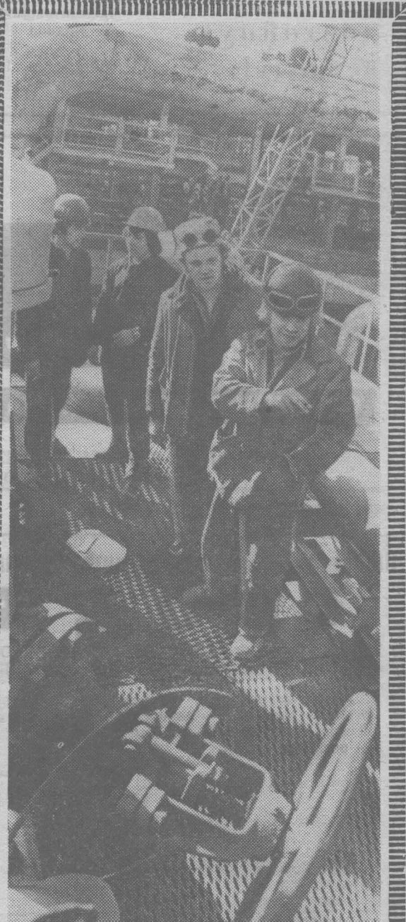
Пятый блок 673 корпуса монтирует бригада Г. Сатинеева из КМУ-1 Сибметаллургмонтажа.
