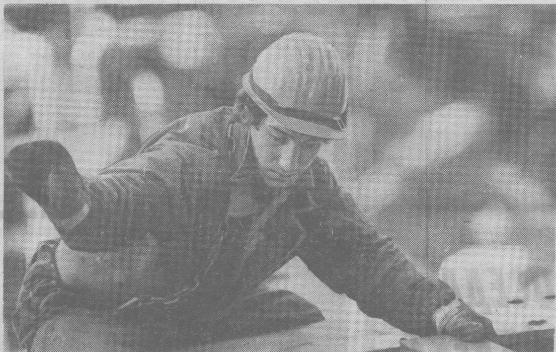
На снимке: монтажник С. Пименов из бригады А. Чердынцева НМУ-1 Сибметаллургмонтажа. Фото Ю. Сергеева.
