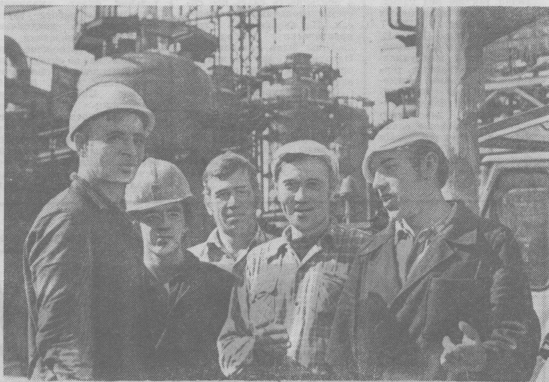
Дружная бригада Н. Т. Зенченко из Союзтеплостроя, опережая нормативные сроки, ведет кладку трубы пусковой котельной. НА СНИМКЕ (слева направо): А. Черемных, С. Сушанский, В. Корчагин, Н. Волобуев, Н. Зенченко.
