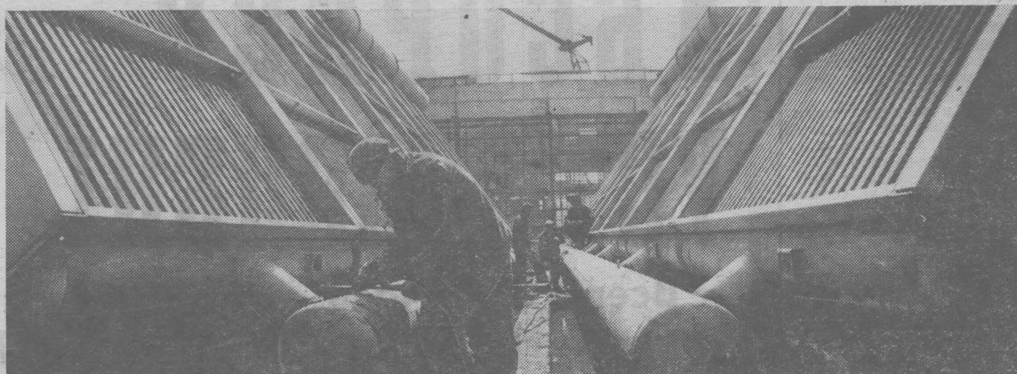
Бригада В. Лаврушина монтировала конденсаторы воздушного охлаждения компрессора синтез-газа.
