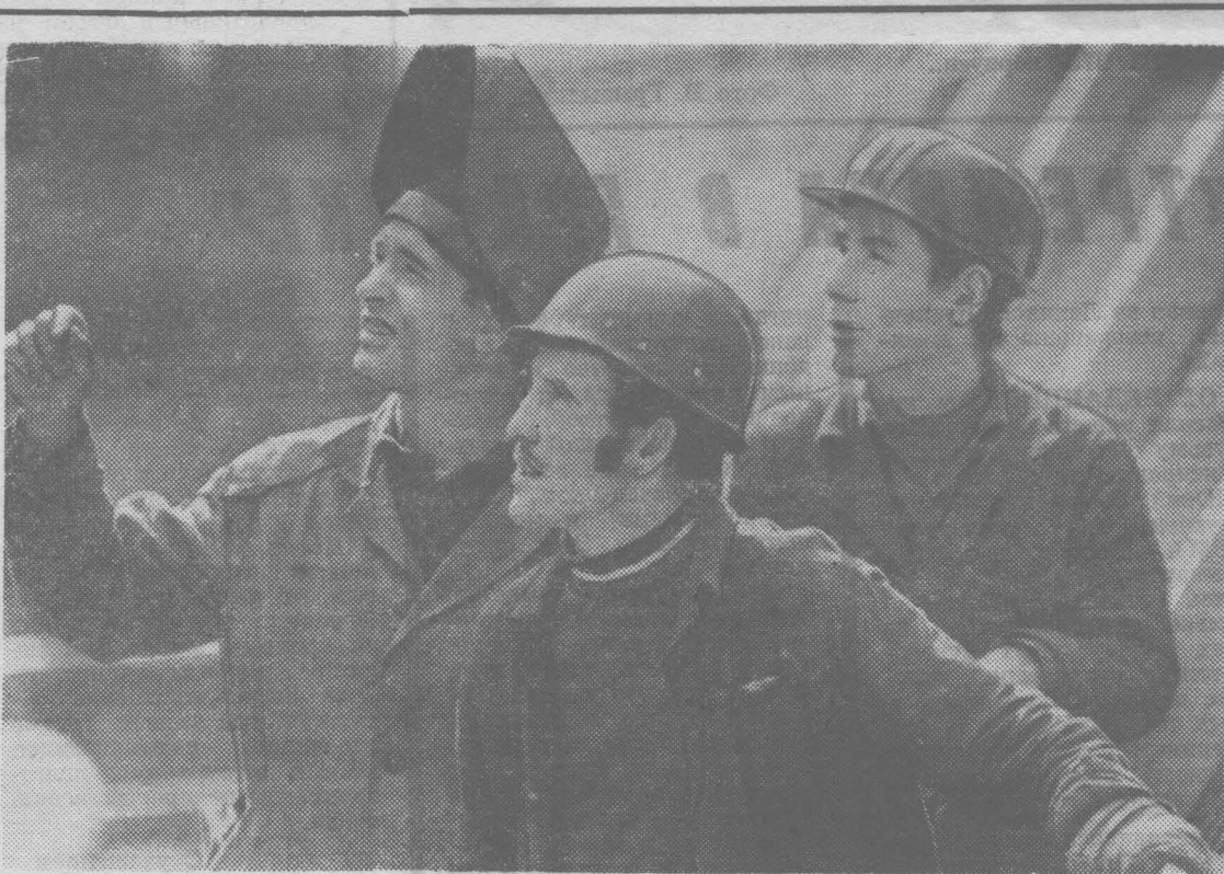
Монтажники Б. Чернавин, Е. Васильев, А. Федьков из бригады В. Лаврушина ведут монтаж воздушных конденсаторов (корп. № 671 А).
