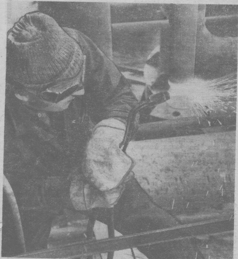
Монтажник НМУ-1 треста СММ Виктор Игорьев из бригады В. П. Алешина готовит трубу для соединения к холодоаппаратам на блоке № 9. Фото В. Грызыхина.
