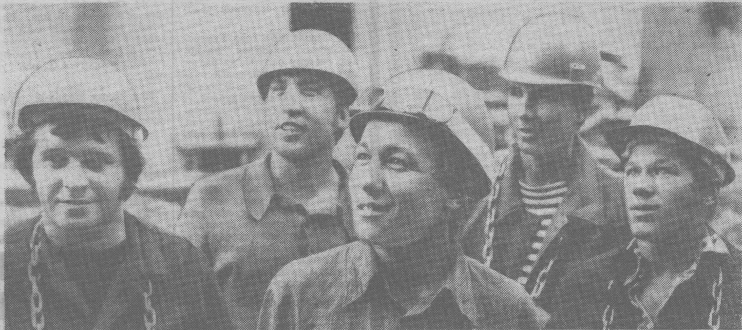
Бригада А. П. Куртаева из КМУ-1 Сибметаллургомонтажа работает в самом центре комплекса — монтирует маршевые лестницы и площадки у реформинга. Фото В. Грызыхина.
