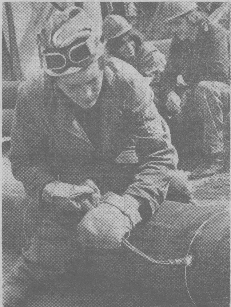
Отлично трудится на строительстве комплекса монтажник Александр Крот из бригады О. Часовельного КМУ-1 Сибметаллургмонтажа.
